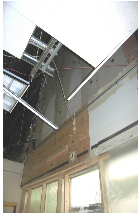
Cavity above window prior to pour
